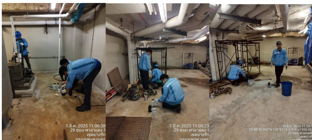
รูปที่ 3.2.1 จุดตรวจวัดคุณภาพน้ำทิ้งบริเวณถังพักน้ำทิ้งภายในคอนโดมิเนียมศาลาแดง เรสซิเดนซ์
